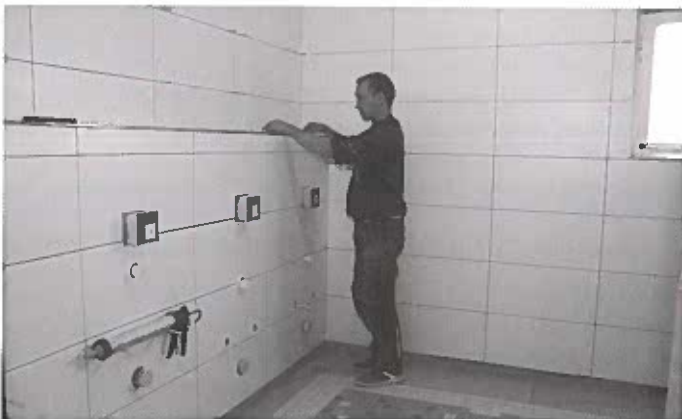
Die Urinal-Anlage im Jungen-WC in der Grundschule Helmlingen wurde in den Sommerferien saniert.
