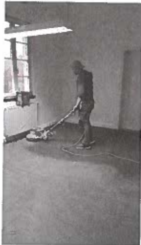
Im Rathaus in Linx wurden die Böden ausgetauscht
