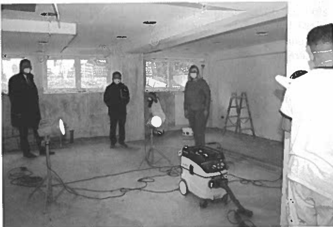
Bürgermeister Michael Welsche (links) informierte sich bei Andreas Fien (Mitte) vom Bauamt und Kindergartenleiterin Tanja Berger (rechts) über den Stand der Bauarbeiten
