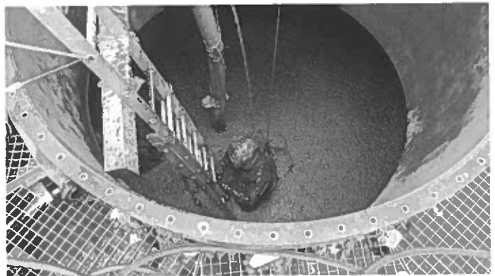
Ein Taucher steigt aus dem Faulturm auf
