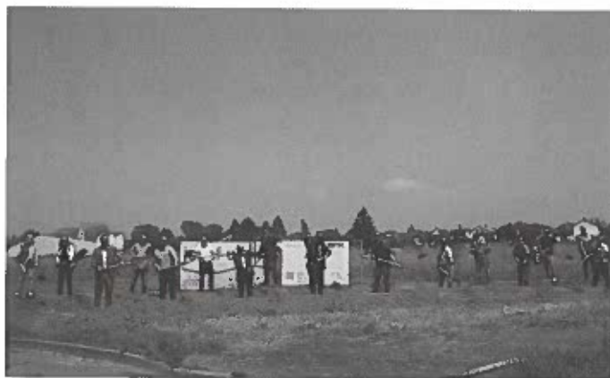
Mit dem symbolischen Spatenstich starten die Arbeiten im Neubaugebiet Neuländ II im Stadtteil Freistett
