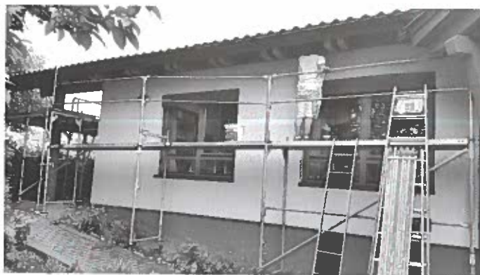
Am Kindergarten in Linx fanden Sanierungsarbeiten statt
