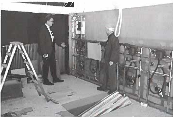
Bürgermeister Welsche (l.) und Rainer Durban (r.) begutachten den Baufortschritt der Toilettenanlage im AFG
