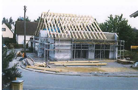
Neubau Feuerwehrgerätehaus: Erster Spatenstich war im Dezember 1986, Schlüsselübergabe bereits 1988.
