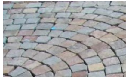
Steinpflaster mit offenen Fugen
