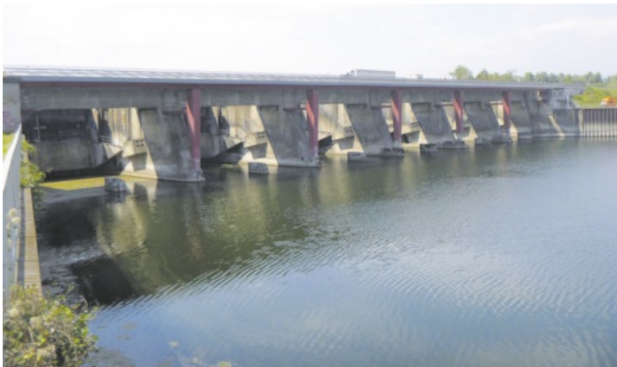
Foto: Wehrbrücke über den Rhein zwischen Rheinau-Freistett und Gamsheim: Die fünf roten Stützen der Geh- und Radwegbrücke erhalten einen neuen Korrosionsschutz. Foto: Regierungspräsidium Freiburg
