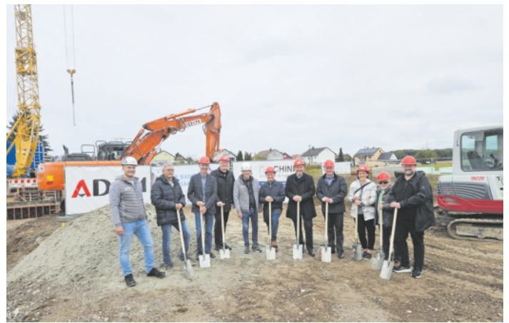
Spatenstich für das neue Wohnhaus der Diakonie Kork im Neubaugebiet Neuland II
