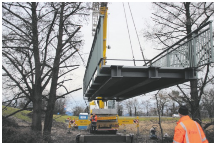
Die neue Brücke über den Galgenbach wird eingesetzt
