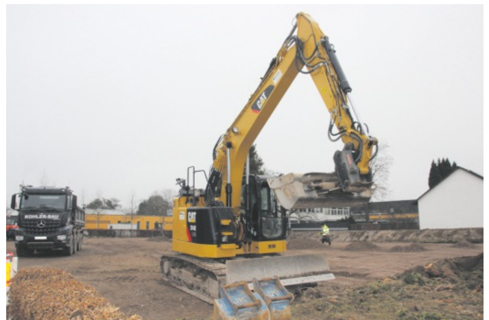
Die Tiefbauarbeiten für die Schulcontaineranlage haben begonnen
