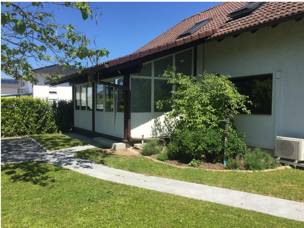
Abbildung 6-2. Blick von Osten auf den Wintergarten und einen Teil der Gartenfläche.
