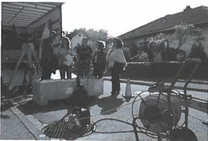
Die Sanierungsarbeiten an den Abwasserkanälen in Honau gehen voran (von li: Mitarbeiter der ausführenden Firma, Nicole Schnurr vom städtischen Bauamt, Bürgermeister Oliver Rastetter, Bauamtsleiterin Julia Hangs und Ortsvorsteherin Annette Fritsch-Acar)
