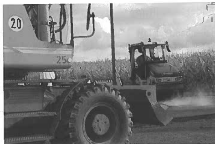
Im Baugebiet Neuland II fanden die letzten Asphaltierungsarbeiten statt
